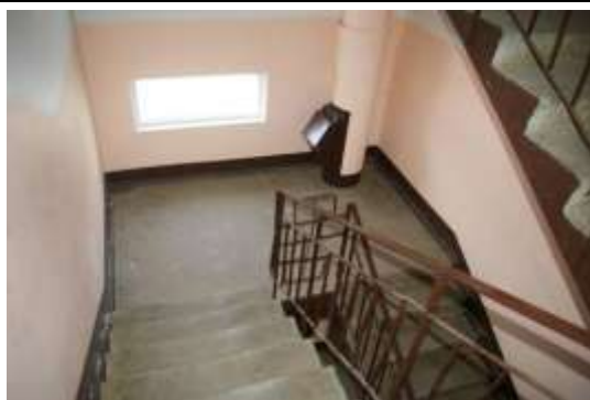
Dzīvojamā ēka ar kadastra apzīmējumu 1700 014 0393 001, koplietošanas telpa
